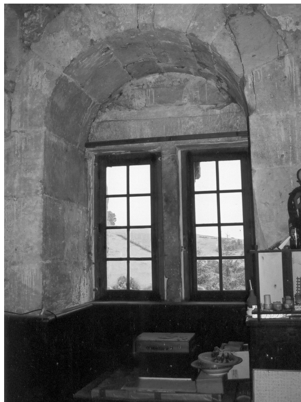
Fig. 12 : la baie du deuxième niveau (photo C.B.)
