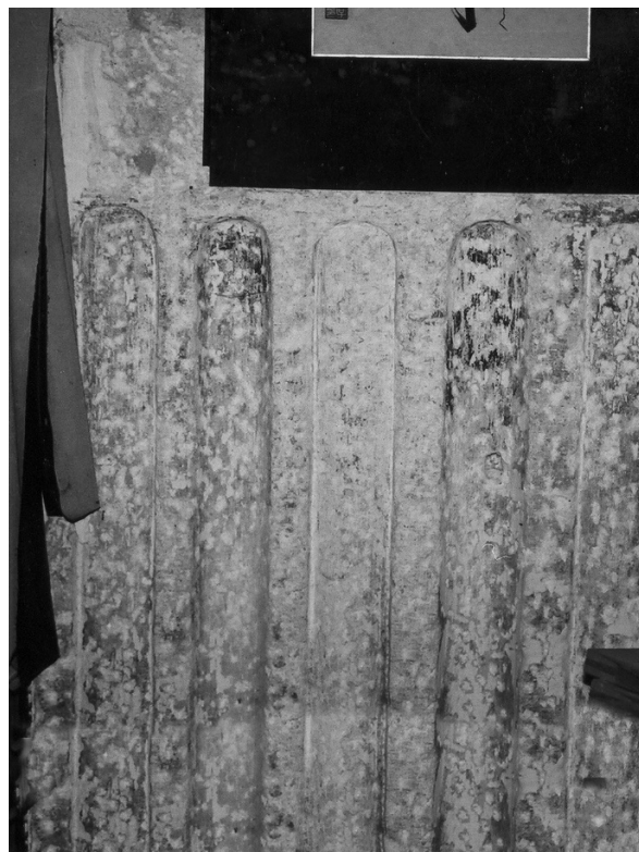
Fig. 14 : détail du pilastre cannelé à gauche de la cheminée (photo C.B.)
