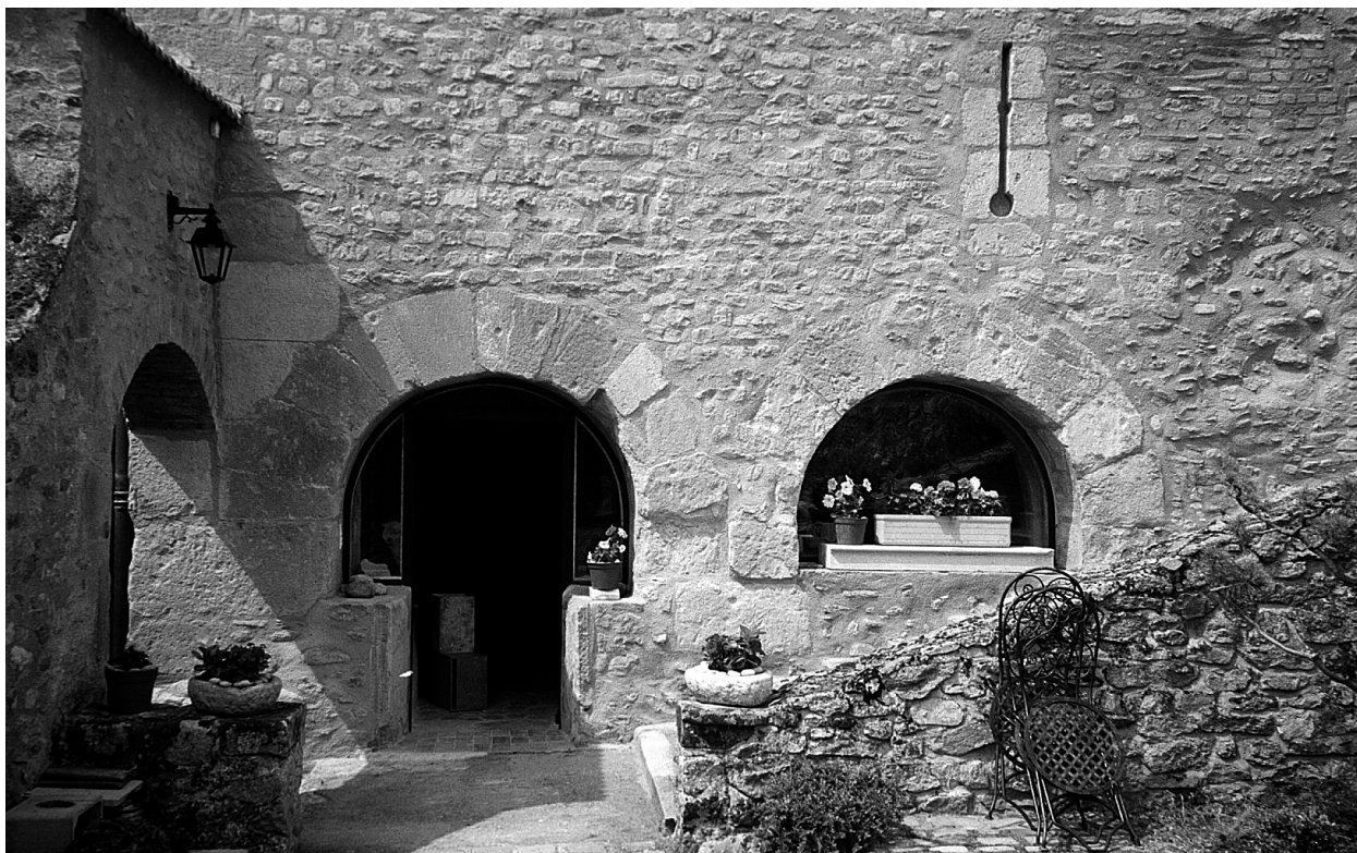
Fig. 17 : les arcades au pied du mur oriental de la maison (photo C.B.)
