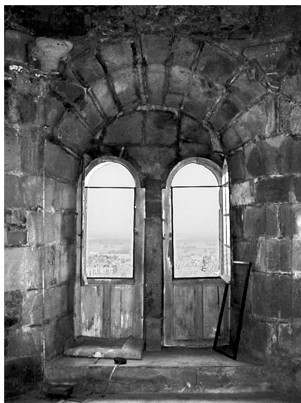
Fig. 15 : baie géminée du troisième niveau, vue de l'intérieur (photo C.B.)
