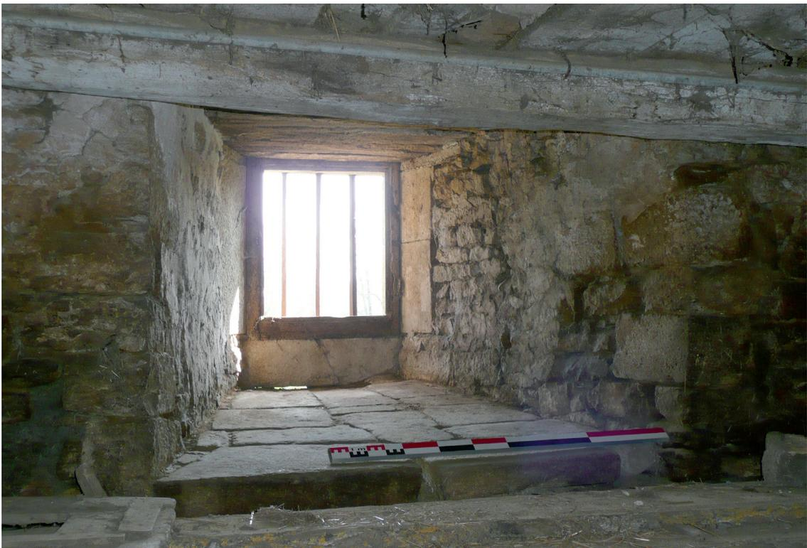
*Fig. 16 : courtine orientale, ouverture reprise à ébrasement interne (cl. A. P.)*
