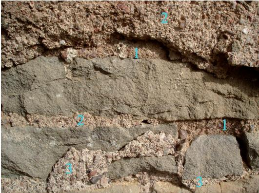
Fig. 3 : détail de la stratigraphie des différents mortiers de la tour-porche.
