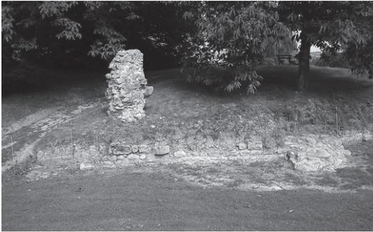
Fig. 29 : la courtine sud-est montre les vestiges de la porterie des *XVI<sup>e</sup>* et *XVII<sup>e</sup>* siècles : un pan de mur, reste du montant droit de la tour porche ; au centre, l'emplacement du pont-levis, entre les deux grosses pierres ; de chaque côté, les bases de deux contreforts (cl. B. G.)
