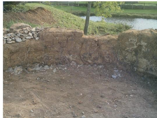
Fig. 17 : la face intérieure du mur du 1<sup>er</sup> étage de la tour ronde septentrionale nous montre l'enduit de sable et d'argile badigeonné en blanc à la chaux (à gauche et à droite). Des fragments de plâtre se situent à la base du mur (cl. B. G.)
