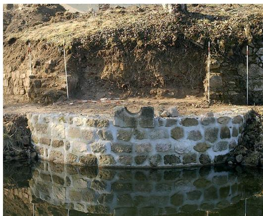
Fig. 23 : la tour demi-ronde orientale après restauration. Au-dessus, les traces d'arrachement et le remblai d'effondrement mis au jour lors de l'établissement du chemin périphérique. La pierre insérée au-dessus de la tour semble être un fragment de siège de latrines. Il a été installé là pour sa sauvegarde (cl. B. G.)
