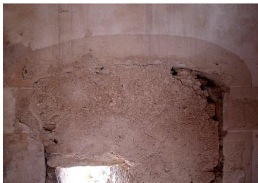
Fig. 12 : détail de la baie en anse de panier des latrines avec son décor de fausses pierres d'origine.
