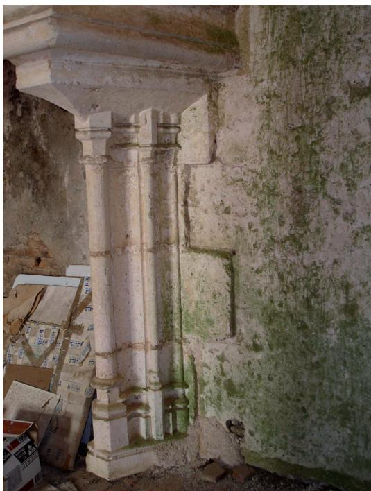
Fig. 10 : montant droit de la cheminée de la salle haute (étage du n° 10 du plan 2). Les pierres sont laissées en relief et se détachent de l'enduit du mur.
