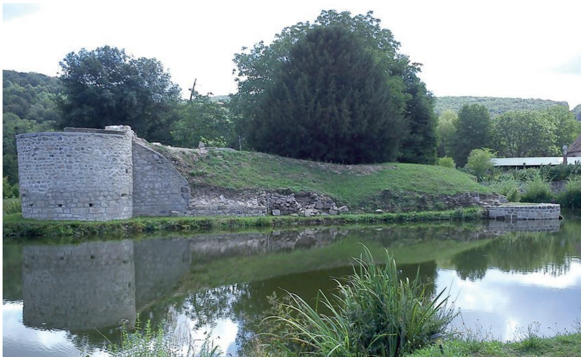
Fig. 26 : la courtine nord-ouest en cours de restauration. De gauche à droite, on reconnaît la tour nord, le mur nord-ouest de la tour d'Alone, la courtine qui sera restaurée sur une hauteur de 0,50 m et la tour ouest. (cl. B. G.)
