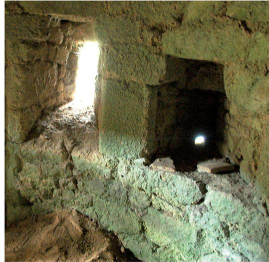
Fig. 16 : deux ouvertures de tir de la tour nord : une canonnière à mousquet et un jour d'aération (cl. B. G.)
