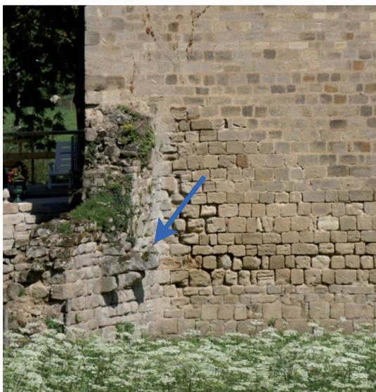
Fig. 12 : détail des corbeaux de latrine de la courtine. (Cl. J. V.)
