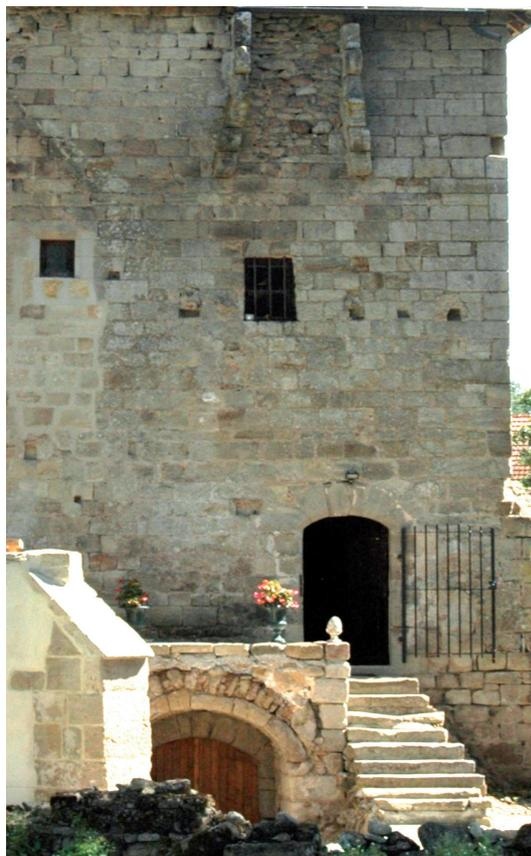
Fig. 27 : disposition de la bretèche au-dessus des portes de cave et d'entrée de la tour. (Cl. J. V.)
