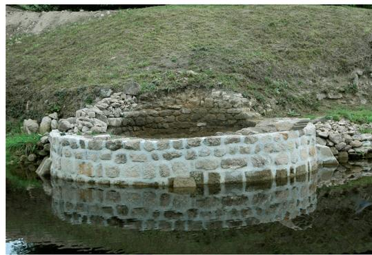
Fig. 25 : la tour ouest, en cours de restauration, montre ses 3 contreforts. En second plan, son mur ne montre pas de porte d'accès au château. À droite, une pierre de corniche est posée sur le mur (cl. B. G.)
