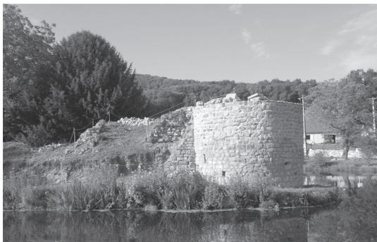
Fig. 11 : la tour ronde septentrionale après sa restauration. À gauche, la face nord-est de la tour d'Alone en cours de restauration. Le contour extérieur des murs non restaurés est matérialisé par une corde blanche. Le mur sud-est apparaît en haut à gauche, avant restauration (cl. B. G.)
