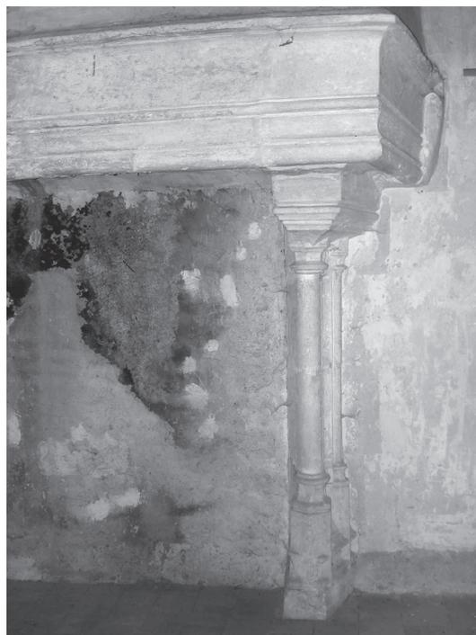
Fig. 9 : montant droit de la cheminée de la salle basse (rez-de-chaussée du n° 10 du plan 2). On distingue les faux-claveaux tracés sur l'enduit du mur pour prolonger en trompe-l'œil les véritables pierres.
