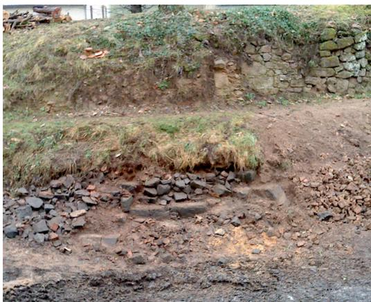
Fig. 22 : l'assise de base de la tour orientale ainsi que les restes de deux contreforts sont bien visibles après la vidange des douves et avant leur restauration. Au-dessus du « chemin des tours », on aperçoit les traces d'arrachement du mur nord de cette tour (cl. B. G.)
