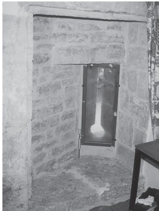
Fig. 24 : orifice de tir, tour ouest, niveau 3, canonnière nord (cl. A. P.)
