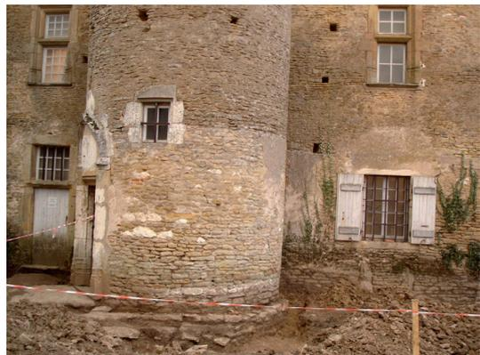
Fig. 19 : vue de l'extérieur de la cour intérieure sur la tour de l'entrée (n° 9 du plan 2) avec les limites de reprise d'enduits ou de rejointoiement limitées à la partie basse.
