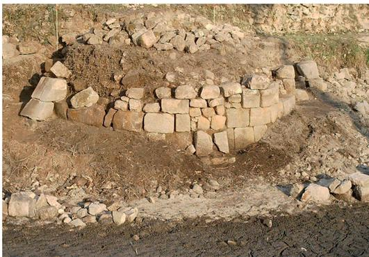
Fig. 24 : les assises de base de la tour ouest, avant restauration, sont bien visibles après la vidange des douves. À gauche, le contrefort nord. Au centre, le contrefort a été remplacé par un remplissage de pierres (cl. B. G.)
