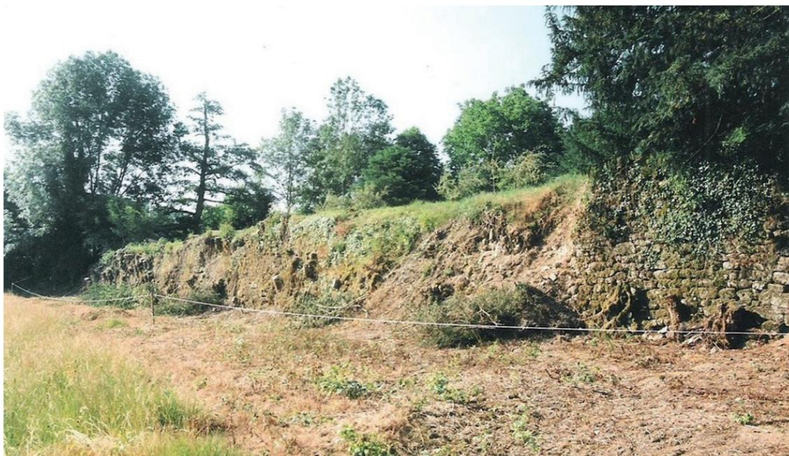
*Fig. 15 : vestiges de l'ancien mur soutenant la terrasse au nord-est. Ce mur a dû être remplacé par un talus en pente douce (cl. B. G. 2004).*
