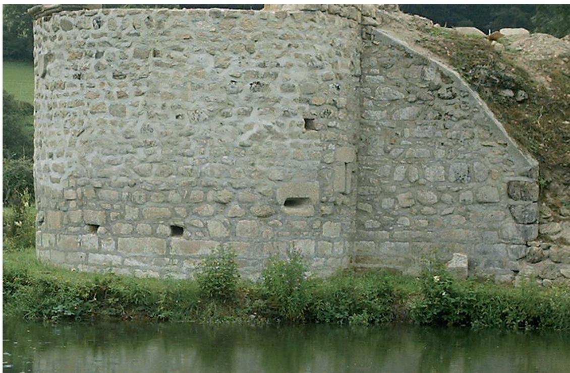
Fig. 21 : les pierres du parement de la base de la tour d'Alone et celles de la base de la tour ronde septentrionale sont en continuité. On voit également la canonnière et le trou d'évent de la tour nord, et le jambage de porte de la tour d'Alone à droite (cl. B. G.)
