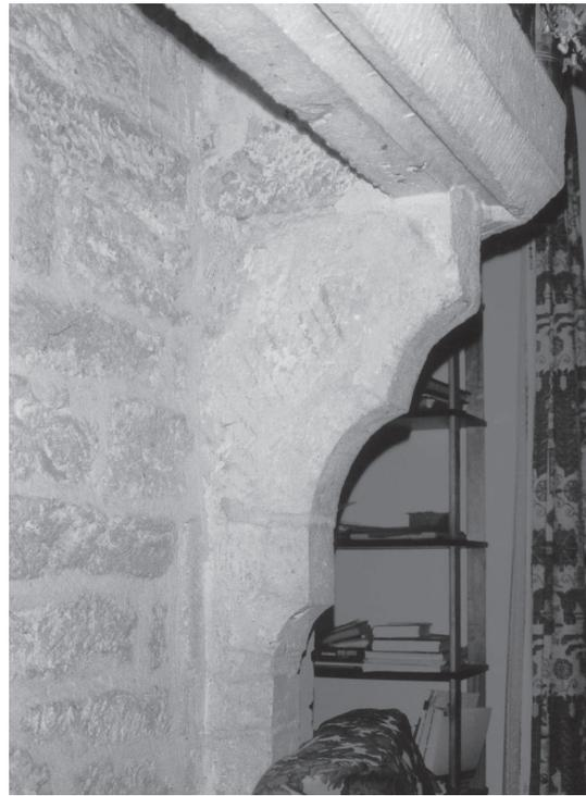
Fig. 22 : cheminée de la tour ouest, niveau 3, mouluration supérieure du montant nord (cl. A. P.)
