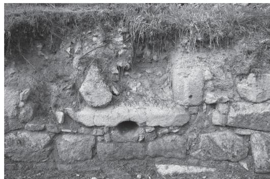
Fig. 28 : partie inférieure d'une fenêtre dans la courtine nord-est montrant l'orifice d'un conduit au niveau de l'appui (cl. B. G.)
