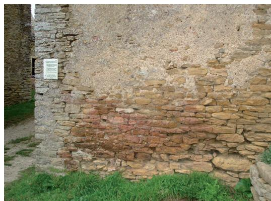
Fig. 5 : traces d'incendie sur la maçonnerie extérieure, à droite du porche.
