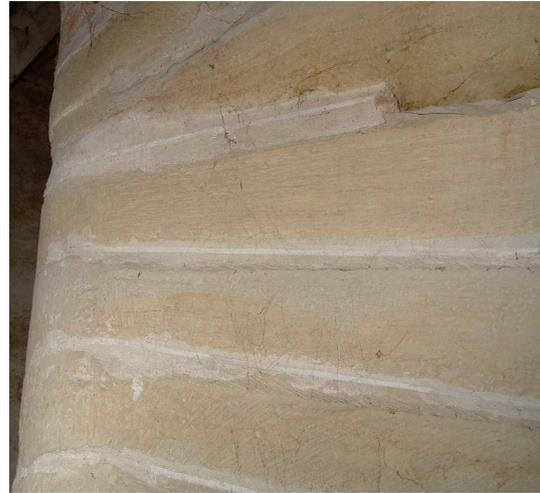
Fig. 17 : vue du dessous des marches de l'escalier en vis, portant le décor d'enduit rosé lissé, avec les joints incisés et surlignés de blanc.
