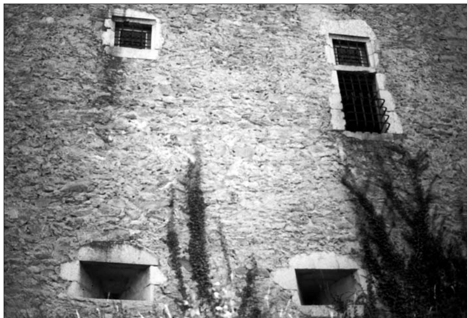
Figure 74. Photo des canonnières de l'aile des gardes du château de Tallard. © N. Nicolas.
