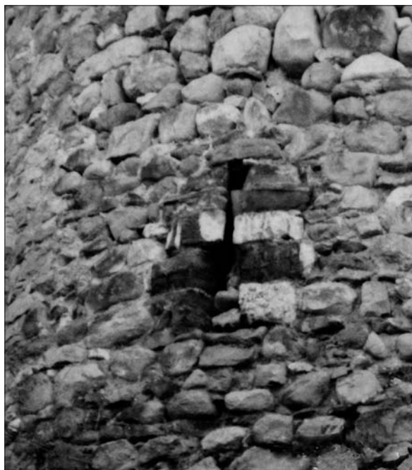
Figure 69. Photo de la fente d'une arbalétrière de la Tour de l'Abattoir d'Embrun. © N. Nicolas.
