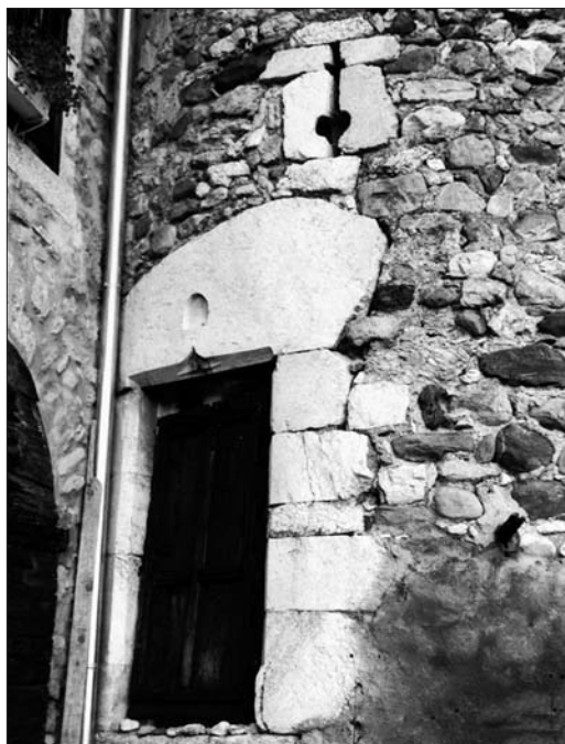
Figure 71. Photo d'une archère-canonnière du château de Rousset. © N. Nicolas.
