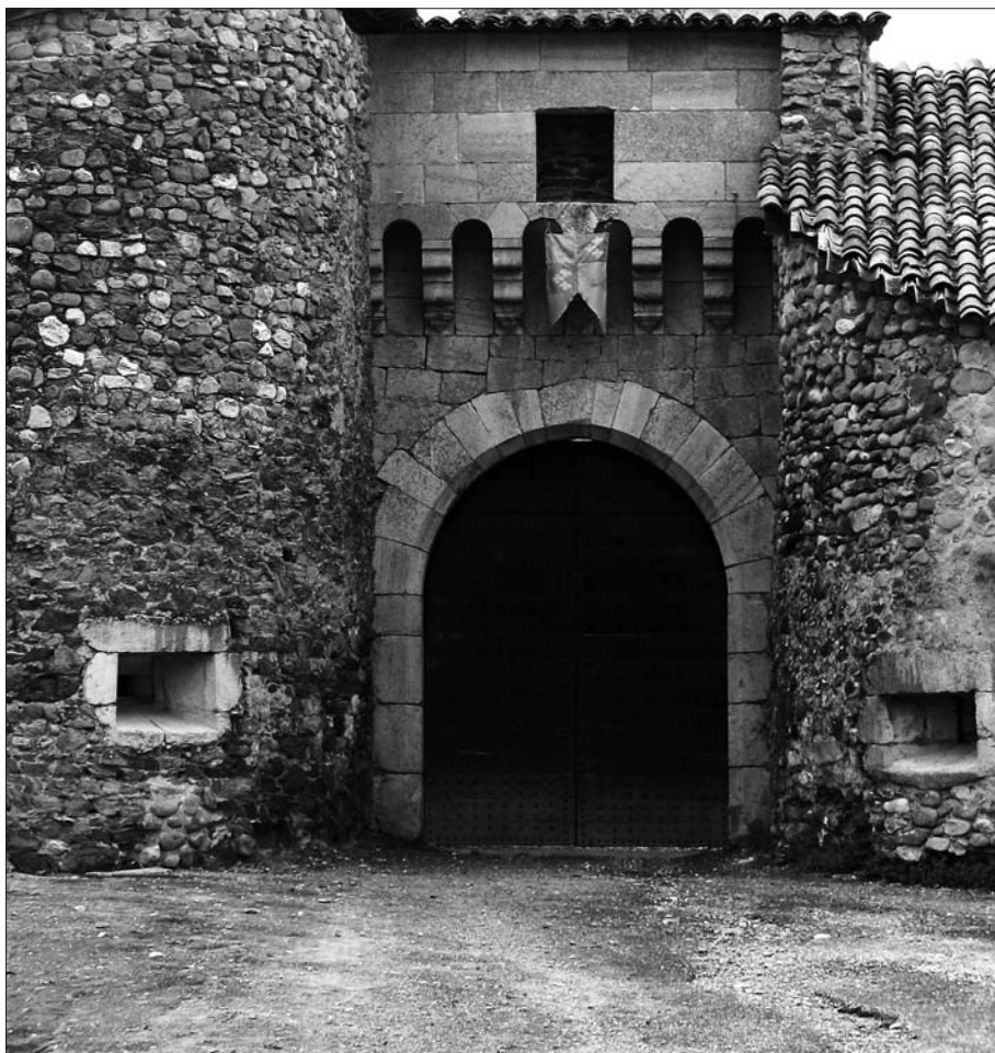
Figure 62. Photo de la bretèche (restaurée) du châtelet d'entrée du château de Tallard. © N. Nicolas.
