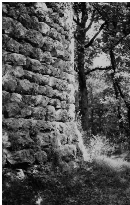
Figure 42. Photo de la base talutée du donjon de La Tourronde. © N. Nicolas.
