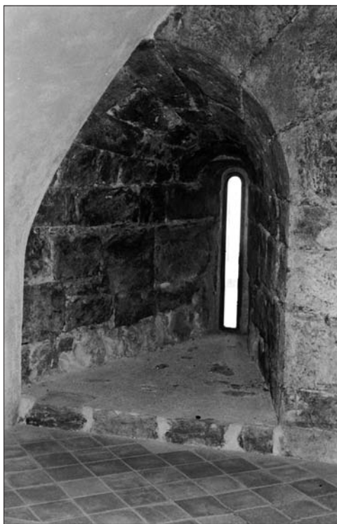
Figure 67. Photo d'une arbalétrière du Mur des Vaudois aux Vigneaux. © N. Nicolas.
