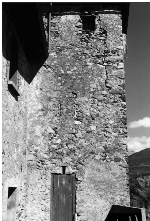
Figure 66. Photo d'une ouverture remaniée dans la maison forte de La Bâtie-Saint-Julien à Savines. © N. Nicolas.
