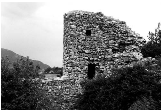
Figure 46. Photo de la tourelle située à l'ouest du château. © N. Nicolas.
