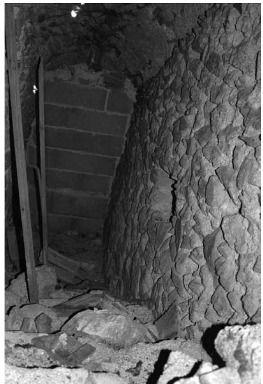
Fig. 30 : escalier intra-muros et porte sur la courtine condamnée, cl. J. V.
