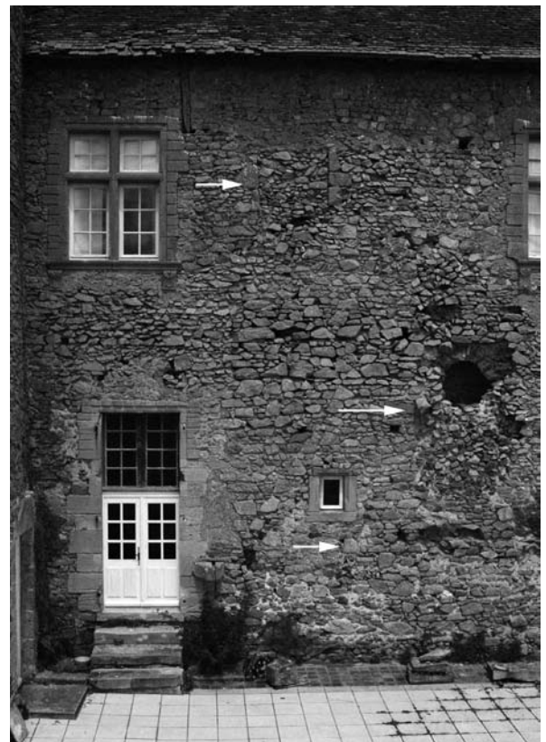
Fig. 11 : extrémité ouest de la façade sud. On distingue de haut en bas les restes d'une baie médiévale, l'escalier pris dans la maçonnerie, et ce qui reste d'une fente de tir. Cl. J. V.
