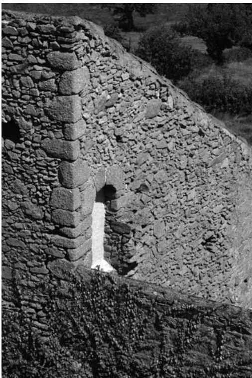
Fig. 29 : porte conduisant de la courtine aux escaliers, cl. J. V.
