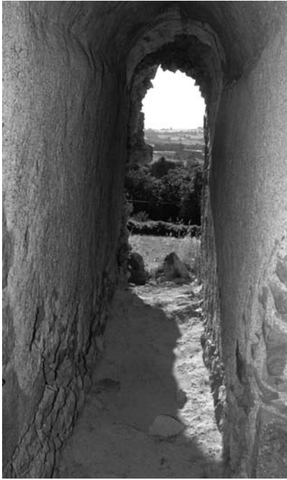
Fig. 19 : galerie nord des latrines. Cl. J.V.
