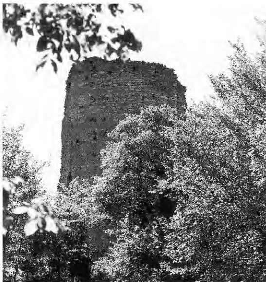
400. COULOMMIERS-LA-TOUR (Loir-et-Cher). On distingue, au sommet de la tour-maitresse du XII e siècle, les encoches destinées à recevoir les poutres du hourdis ; en-dessous, porte d'accès, elle-même surmontée d'une bretèche de bois (?).
