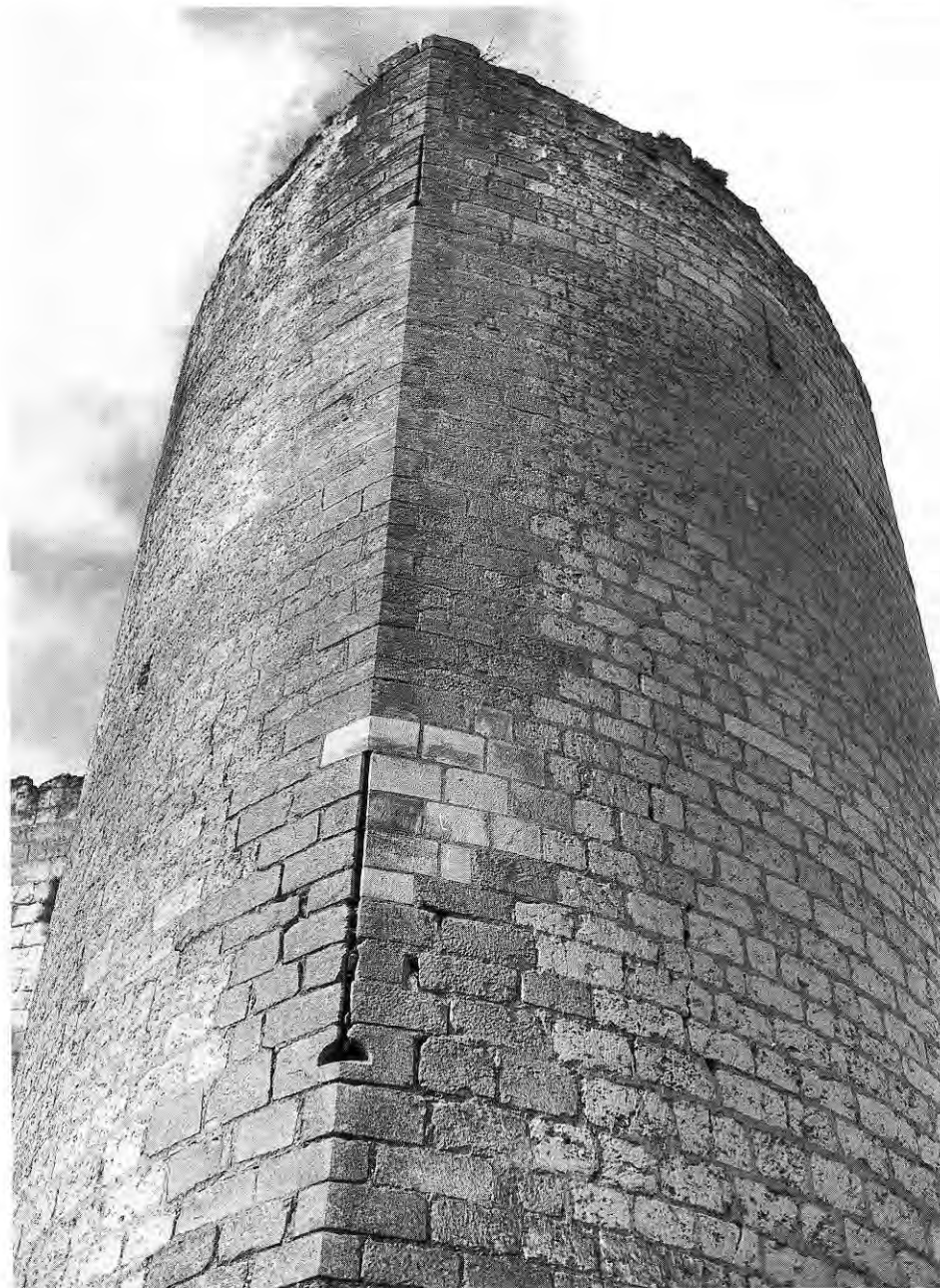
326. LOCHES (Indre-et-Loire). Archères à étrier semi-circulaire d'une des tours en amande, attribuée aux années 1190-1205.
