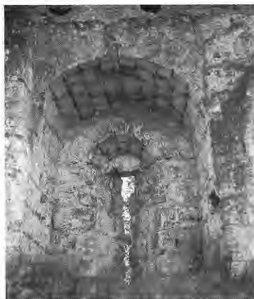
326. LOCHES (Indre-et-Loire). Archères à étrier semi-circulaire d'une des tours en amande, attribuée aux années 1190-1205.
