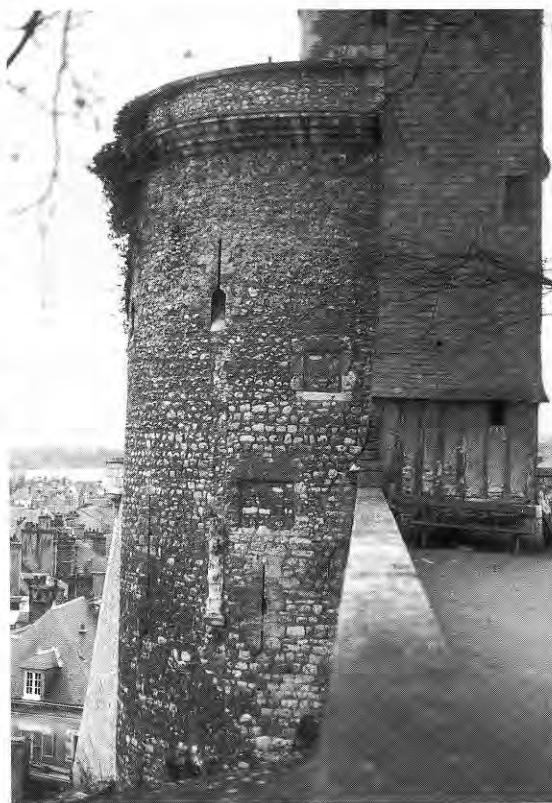
347. BLOIS (Loir-et-Cher). Tour du Foix (XIII e siècle ?). On note la présence d'archères à étriers à tous niveaux : au niveau inférieur, les étriers sont triangulaires, alors qu'ils sont rectangulaires surmontés d'un demi-cercle au-dessus.
