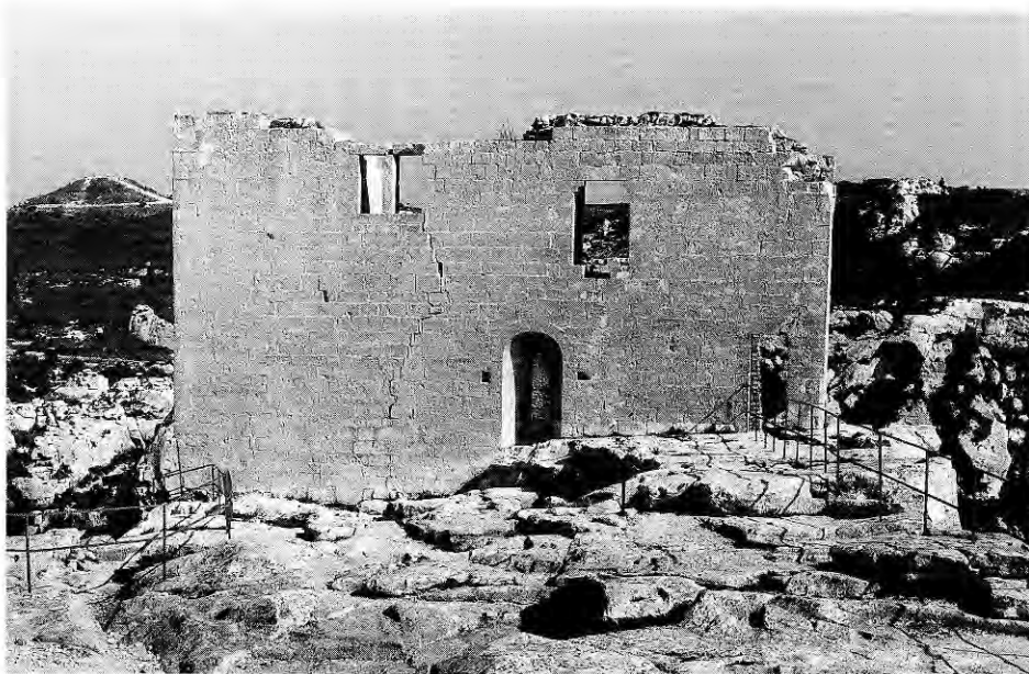
223. BAUX-DE-PROVENCE (LES) (Bouches-du-Rhône). Tour-résidence de la fin du XIII e ou début XIV e siècle. Noter les fenêtres trilobées à voussure au rez-de-chaussée, les fenêtres rectangulaires à meneau au premier étage.
