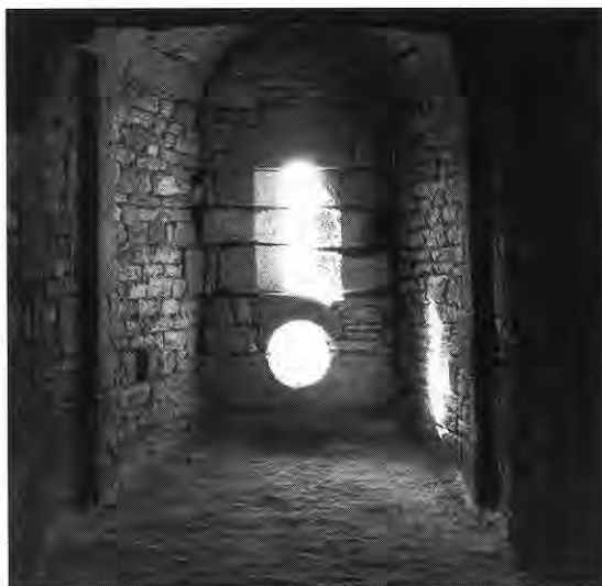
379. SARZEAU (Morbihan) : Château de Suscínio. Niche de canonnière dans la tour neuve de Jean V (avant 1437). Noter la présence de l'abri pour tireur sur le côté, et, dans les flancs de l'ébrasement, le logement de la poutre servant pour supporter les armes et en absorber le recul (cf. fig. 371).
