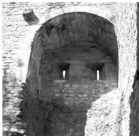
323. GISORS (Eure). Vue d'une archère double sous niche plein cintre, datable des années 1180.
