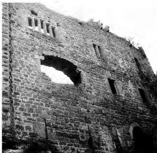
243. OTTROTT (Bas-Rhin) : Château de Birkenfels. Logis XIII e siècle, avec des fenêtres rectangulaires à meneau, et aux deux étages nobles, des claires-voies à baies rectangulaires.
