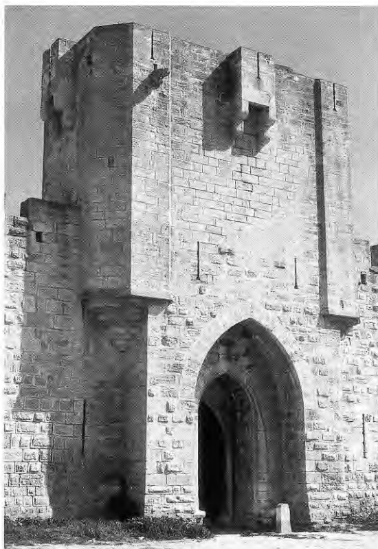
395. AIGUES-MORTES (Gard). Tour-porte de l'enceinte, au chemin de ronde garni de bretèches contrôlant les entrées de la tour.
