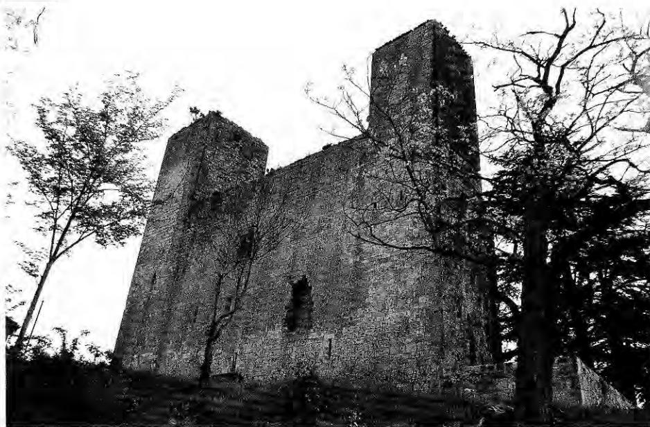
77. SAINTE-MÈRE (Gers). Vue de la salle à tours édifée dans le dernier quart du XIII e siècle.
