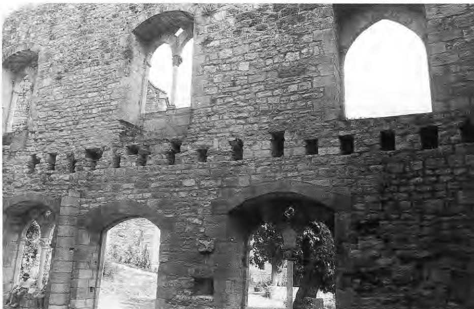
282. BRUNIQUEL (Tarn-et-Garonne). Fenêtres du logis. Noter les roses, et les emplacements des scellements pour les gonds des vantaux.
