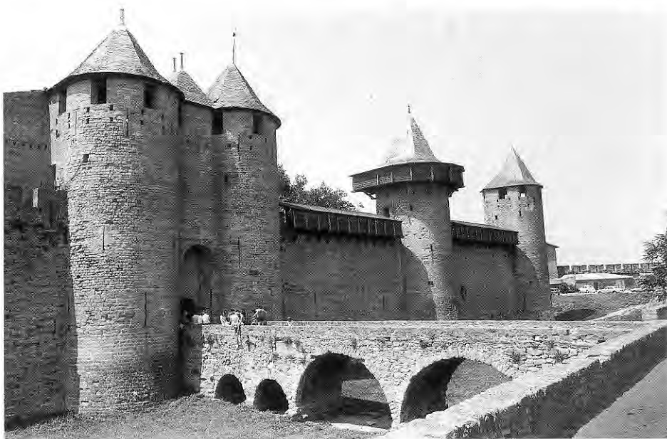
401. CARCASSONNE (Aude). Château royal, bâti vers 1240. Noter les trous de boulin des hourds sur les tours non restaurées ; chaque support était constitué par deux poutres, tel que ceci a été restitué sur la tour intermédiaire.
