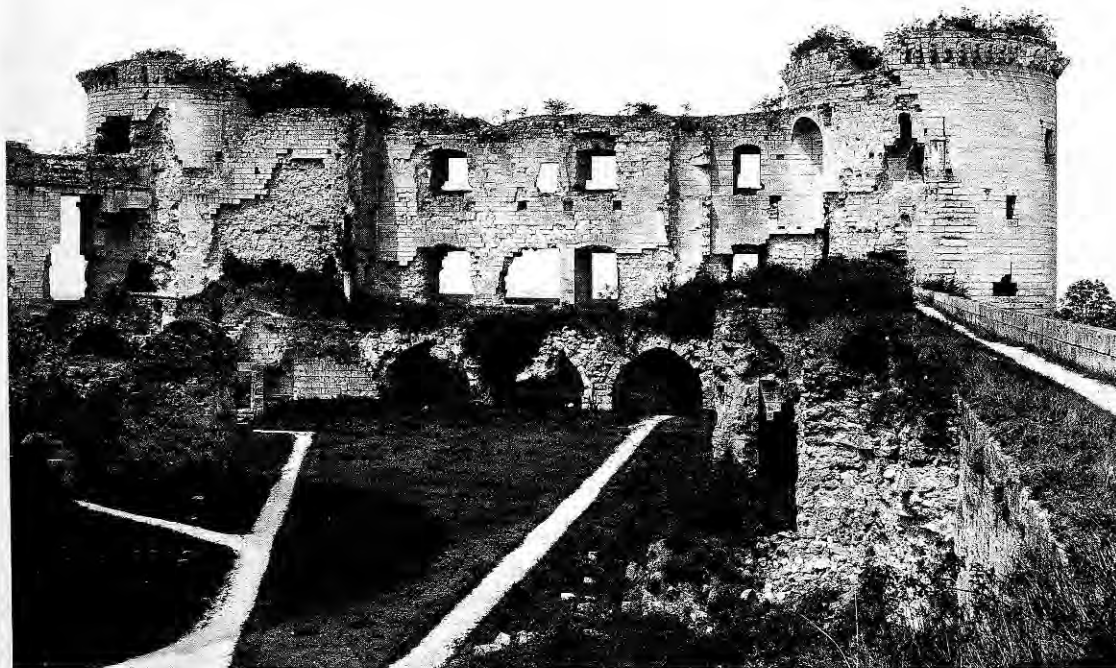
177. COUCY-LE-CHATEAU (Aisne). Vue du logis antérieure à la Première Guerre mondiale. De gauche à droite, après la tour d'angle, le massif contenant le four du poêle et au-dessus la garde-robe ducale ; la salle des Preuses et au-dessus la chambre de parement ; l'escalier privatif ducale ; une chambre non identifiée, et au-dessus la chambre ducale, agrandie au XIV e siècle grâce à une trompe. La salle de la tour, à ce niveau, devait être affectée au couchage ducale ; on aperçoit les restes de la latrine en encorbellement qui fut ménagée pour son confort. La porte ouverte permettait au duc de se rendre dans les galeries qui occupaient la courtine de droite (Cl.Lefèvre-Pontalis, Arch.M.-H.-SPADEM).
