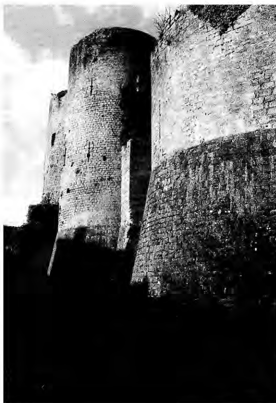
193. VILLANDRAUT (Gironde). Vue du front de l'entrée du château. On reconnaît, flquant l'une des tours d'entrée, un massif rectangulaire formant l'enveloppe d'une latrine en encorbellement médiévale ; ce chemisage a été réalisé au XVI e siècle.
