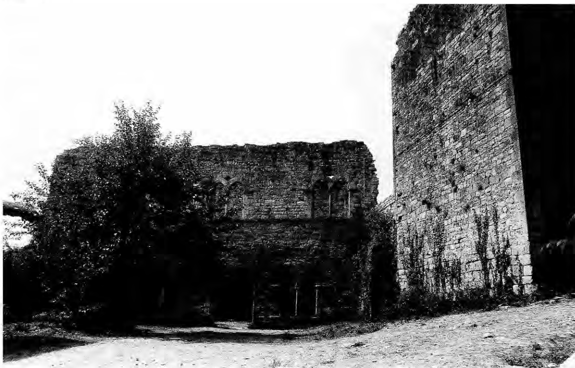
51. BRUNIQUEL (Tarn-et-Garonne). Vue du logis noble dans l'enceinte du château. À gauche, le logis à deux niveaux, derrière lequel se trouvent des dépendances aujourd'hui enfouies ; à droite, la tour maîtresse, du type tour-beffroi .
