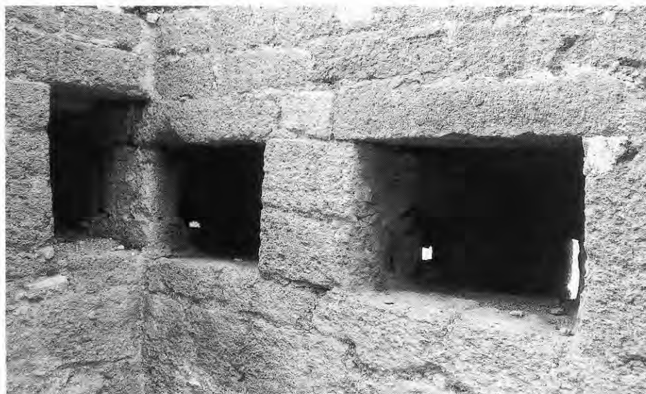
366. CHAMARET (Drôme). Vue des embrasures du logis noble de la basse-cour (XIII e siècle). Les points lumineux sont les orifices de tir ; on peut se rendre compte de la difficulté du tir, et du faible taux de couverture.
