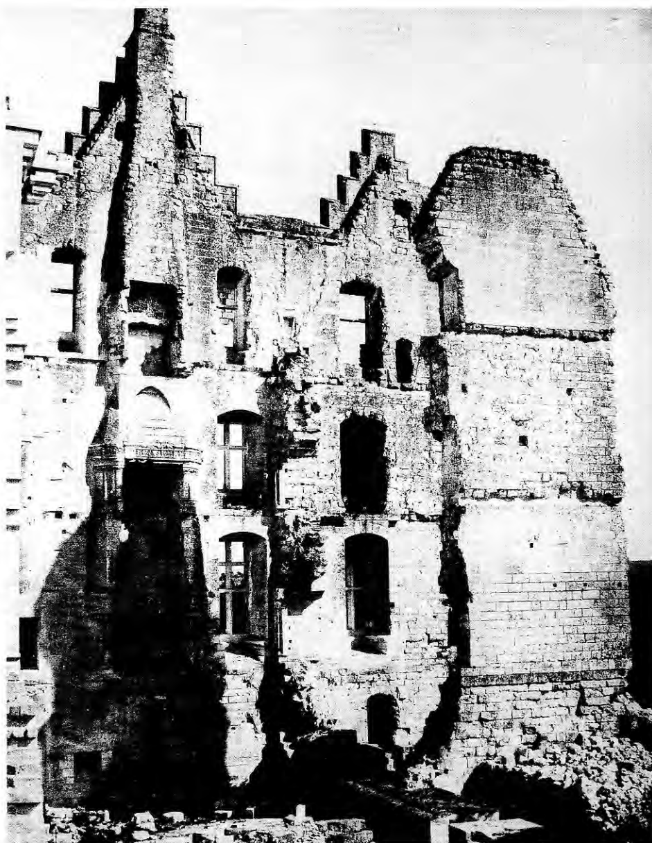
63. PIERREFONDS (Oise). Vue intérieure du "donjon", antérieure à la restauration de Viollet-le-Duc. On reconnaît, de gauche à droite, le mur pignon des salles superposées, et, à droite, le mur pignon des chambres, avec au devant le mur de refend séparant la chambre de parement de la chambre seigneuriale. L'étage noble est reconnaissable au décor de la cheminée de la salle . (Cl.Arch.M.-H.SPADÉM)
