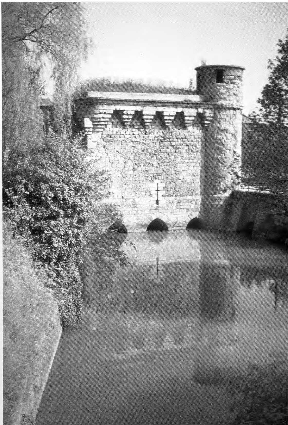
354. CAMBRAI (Nord). Tour des Arquets, de la fin du XIV e siècle, munie d'une archère à étrier bas de grande taille, et d'un croisillon.
