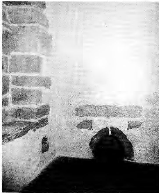
204. BRIDORÉ (Indre-et-Loire). Orifice d'entrée de l'hypocauste.
