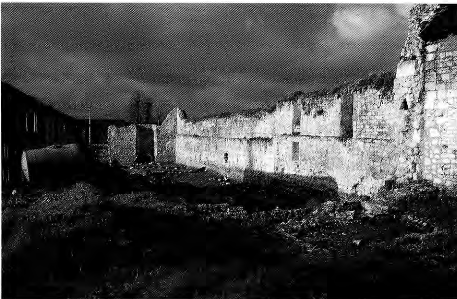
23. SAINT-MARTIN-DE-BOSCHERVILLE (Seine-Maritime). Vue des restes du manoir seigneurial des comtes de Tancarville bâti à l'un des angles de l'enceinte abbatiale ; au fond, le pignon de la grande salle , à laquelle succédait un logis et la chapelle, visible sur la droite.
