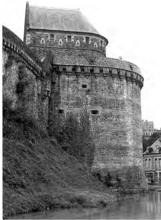
390. FOUGÈRES (Ille-et-Vilaine). Les trois tours à canon du château de Fougères, bâties après 1470, fournissent le plus bel exemple de l'évolution vers la canonnière à ébrasement externe "à la française".
