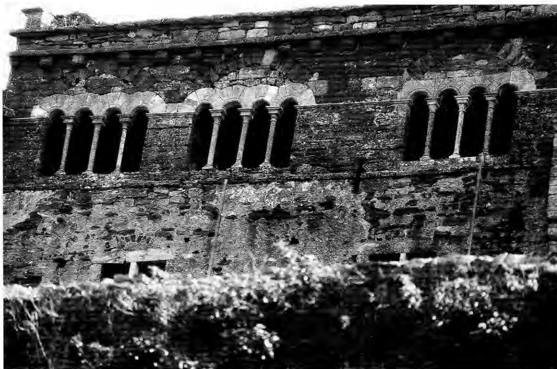
217. PRUDHOMAT (Lot) : Château de Castelnaud-Bretenoux. Claire-voie sous arc de décharge de la tour-salle (début XIII e siècle).
