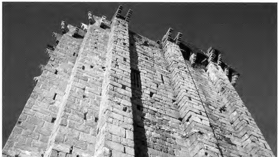
412. SAUGUES (Haute-Loire). Tour-résidence à contreforts dotée tardivement d'une couronne de mâchicoulis ; comme au bâtiment des Mâchicoulis du Puy, la difficulté de ceinturer les contreforts par les mâchicoulis en arcs sur consoles a conduit les constructeurs à ménager sur chacun d'eux de petites bretèches.
