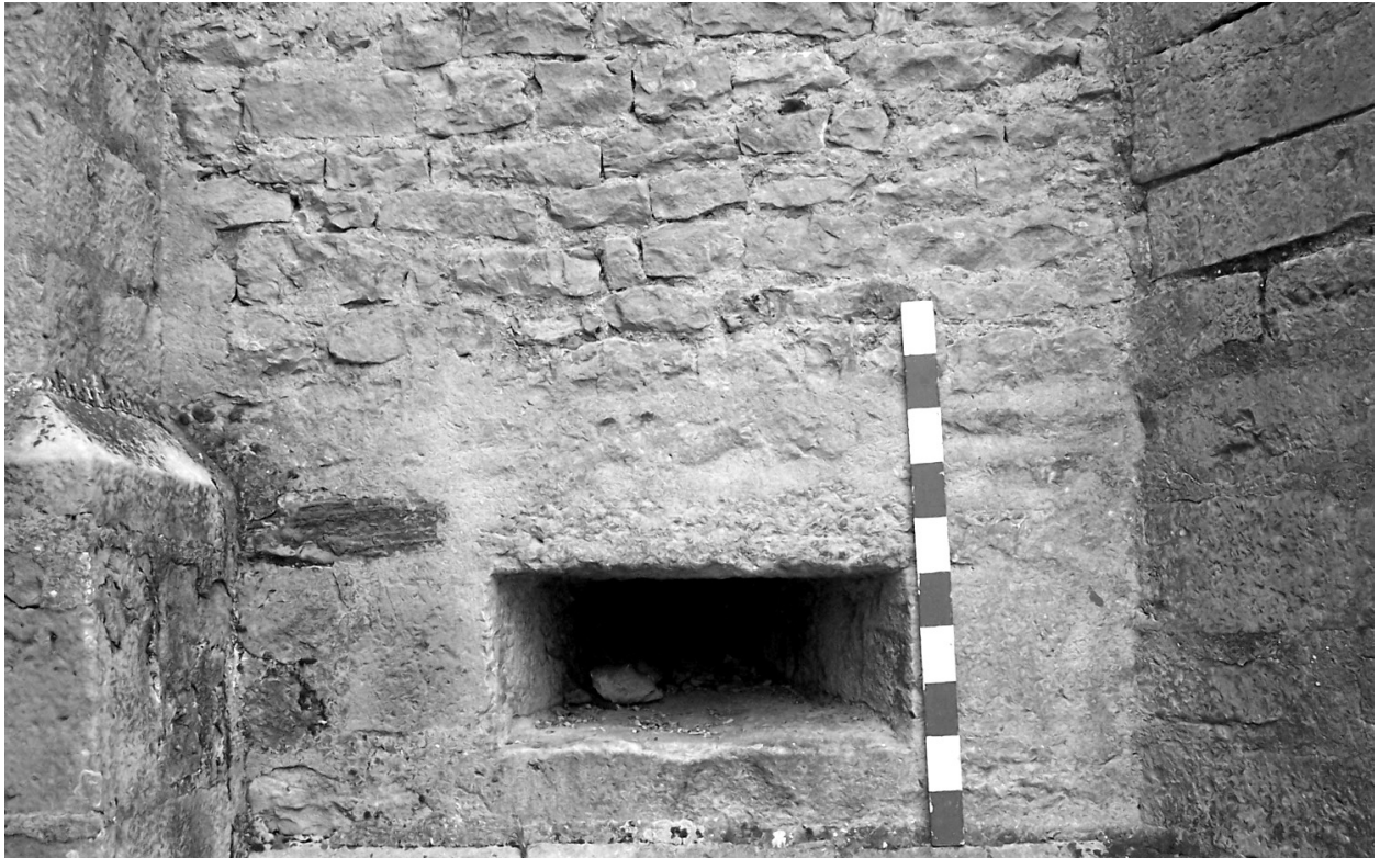
Fig. 23 : canonnière à la française à la base du clocher de l'église de Sermizelles (89).
