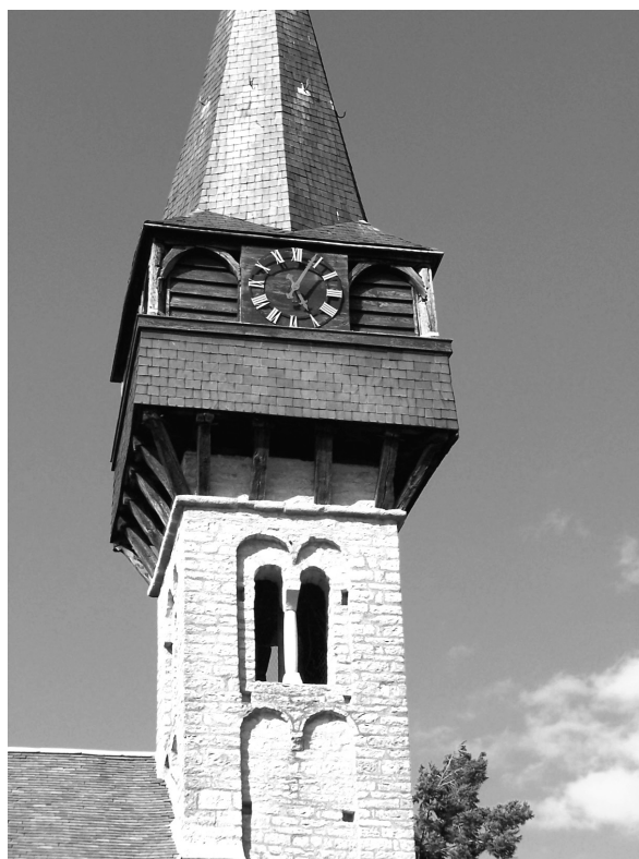
Fig. 31 : vue des vestiges du hourd sur le clocher de l'église de Laizé (71).
