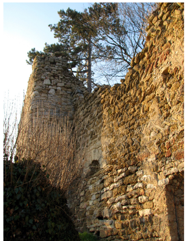
Fig. 12 : face sud du bâtiment 2 avec son appareillage en opus mixte (photo F.B.)
