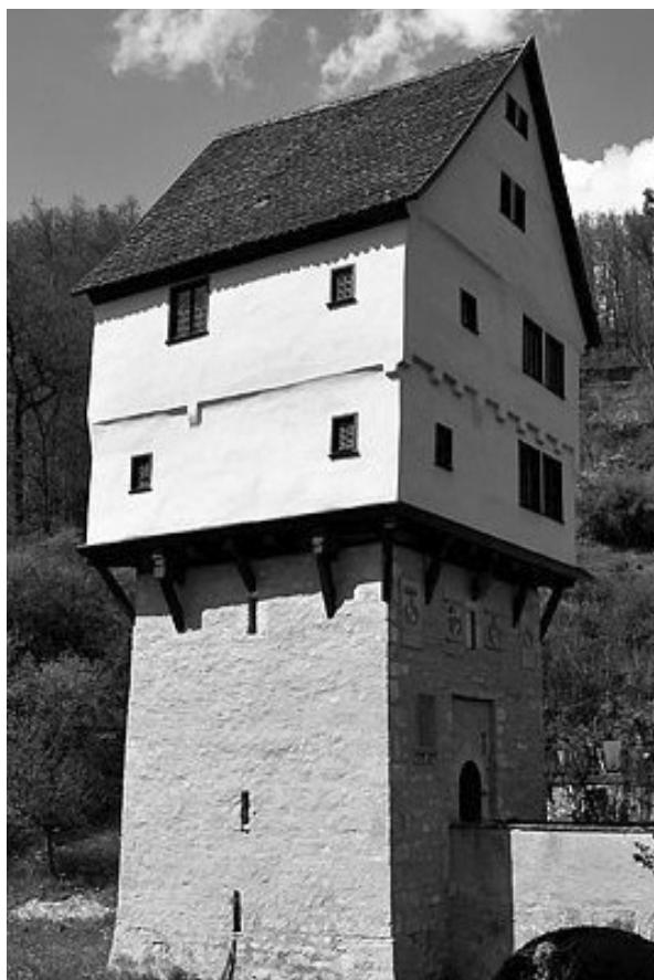
Fig. 7 : exemple de tour mixte pierre et bois : le château Toppler à Rothenburg ob der Tauber (photo Edward M., 2009, Panoramio).
