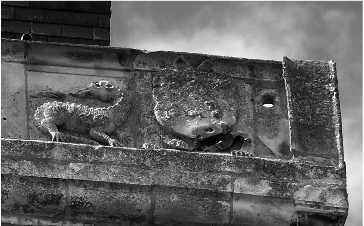
Fig. 32 a : détail des salamandres et des canonnières sur le parapet de l'église de Chevannes (89).
