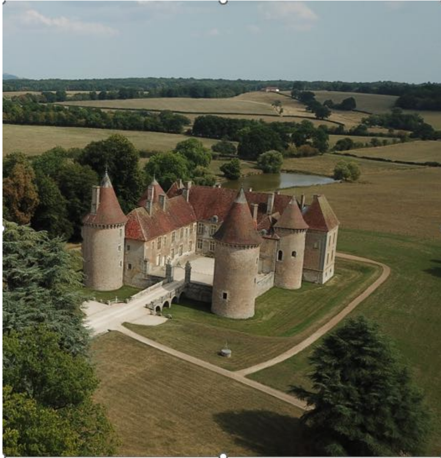
Fig. 11/3 - Vue aérienne du château vers le nord-est
