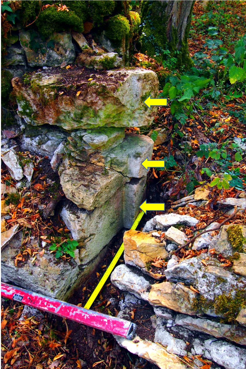
Fig. 17 – Les flèches jaunes indiquent la feuillure (ancienne ouverture ?)
