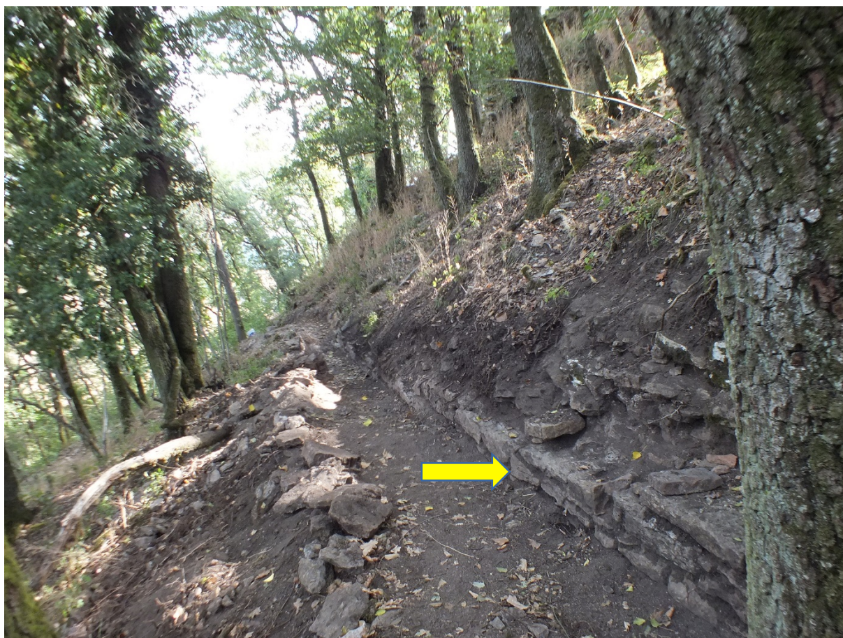
Fig. 8 - Portion de courtine visible entre les deux tours semi-circulaires (flèche jaune).
