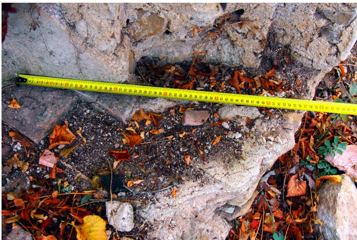
Fig. 12 – Largeur de l'un des ébrasements (0,55 m).
