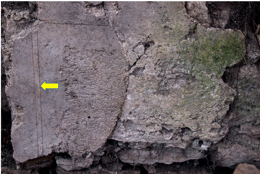
Fig. 16 - La flèche jaune indique le décor de faux-joints blancs d'un parement intérieur.
