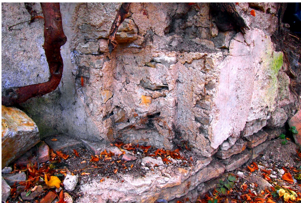
Fig. 13 – Les redents de l'ébrasement de cette niche, cassures de la pierre ?
