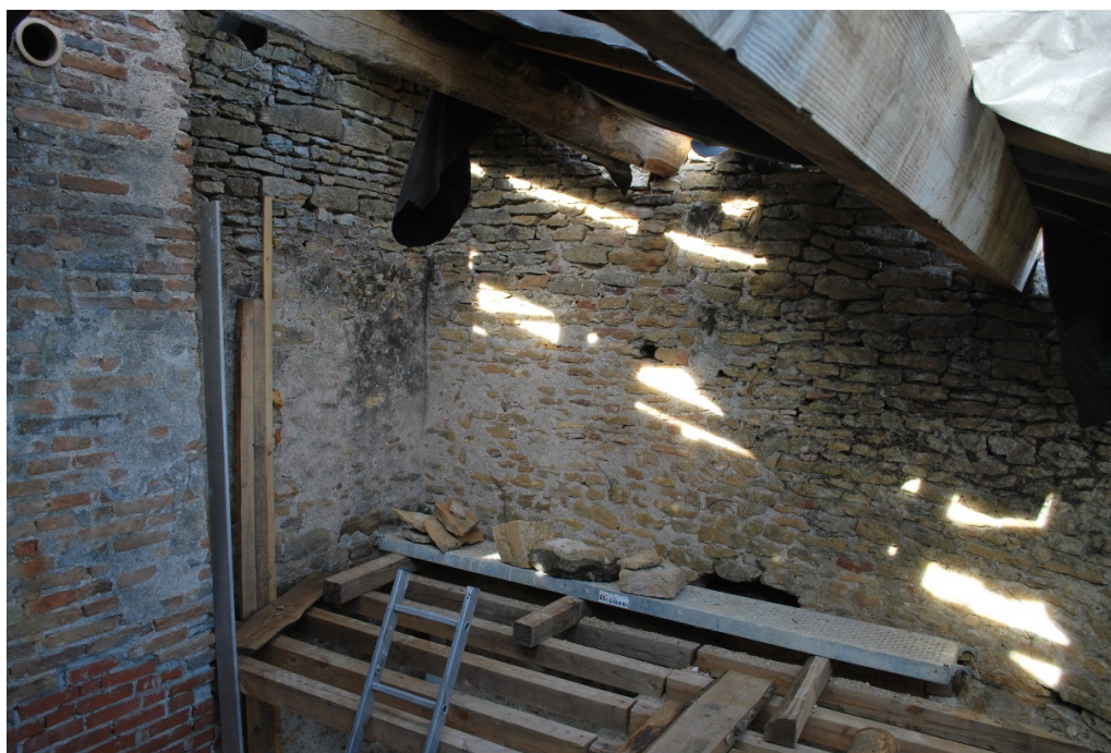
Fig. 3 : Le niveau 4 de la tour du Jeu de Paume en cours de consolidation et de couvrement.
