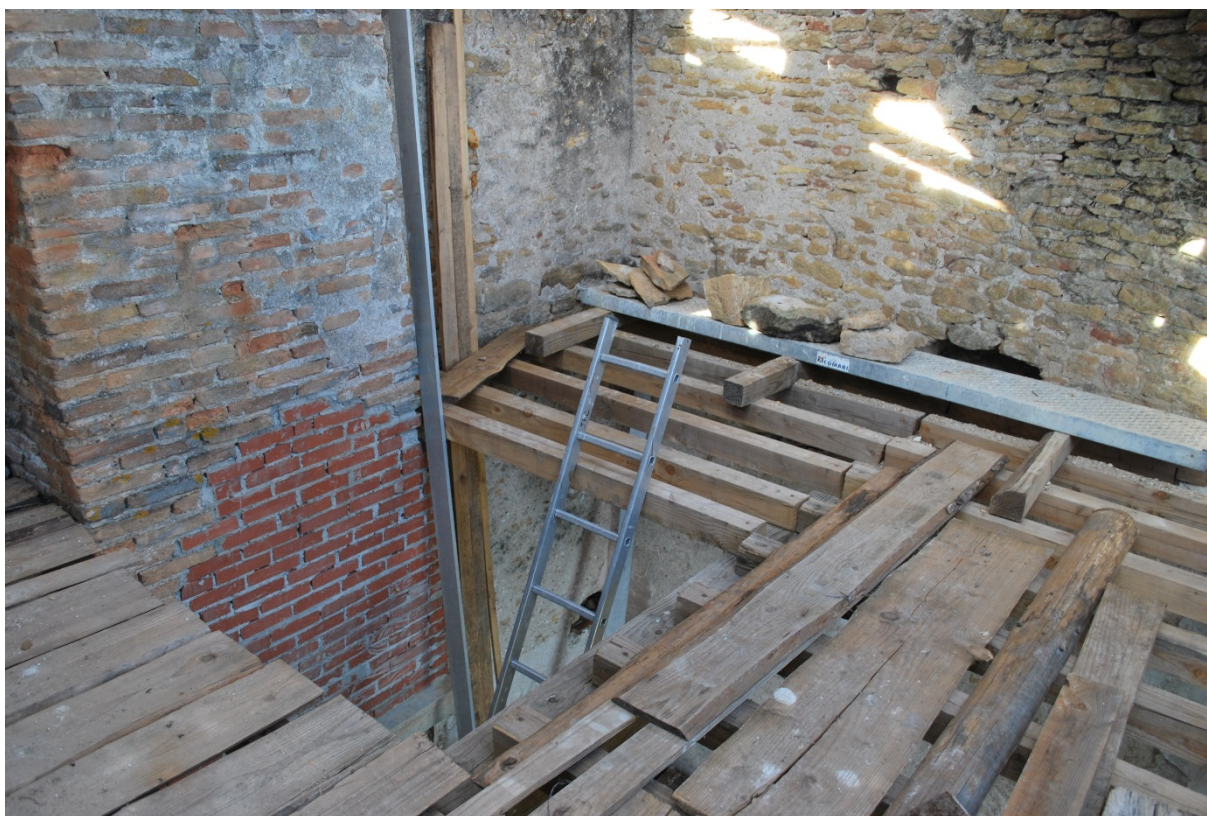
Fig. 4 : Autre vue du niveau 4 de la tour du Jeu de Paume. Confection d'un plancher.
