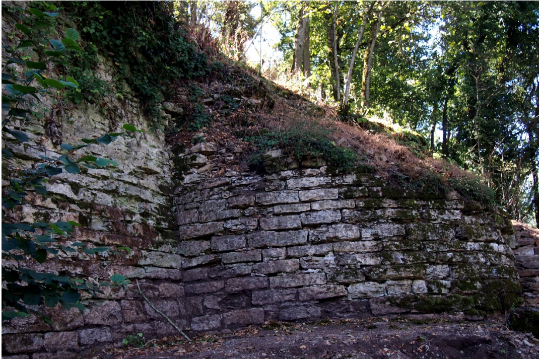
Fig. 5 : Tour semi-circulaire liaisonnée au mur nord du logis d'Amboise, relevée lors d'une campagne précédente.
