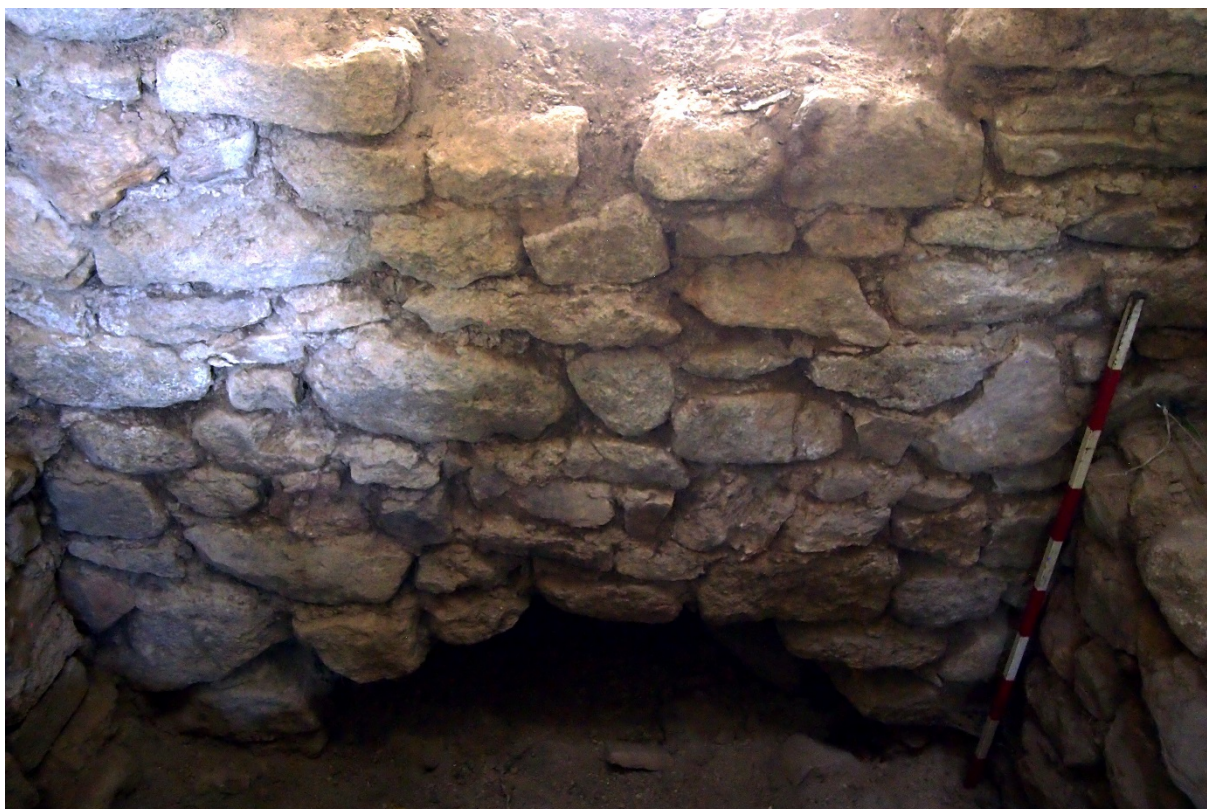
Fig. 6 - Tour-porte. - Fondations d'un mur soutenant une porte (peut-être originelle ?)
