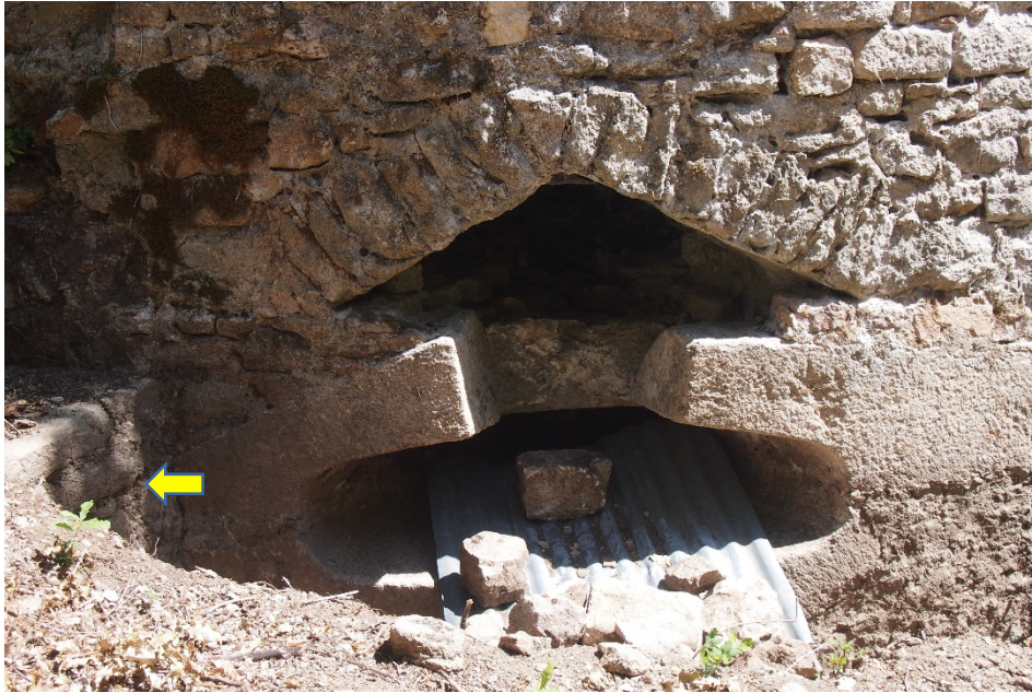
Fig. 8 Tour d'artillerie, bouche à feu dégagée avec à gauche départ d'un mur de courtine (flèche jaune).
