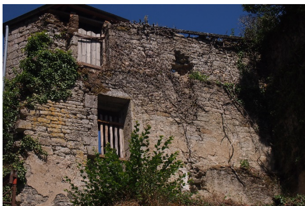
Fig.3 Tour-porte face intérieure.
