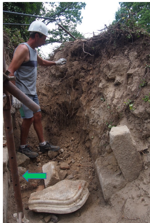
Fig.9 Remblai gênant la pose de l'échafaudage (flèche verte) Fig.10 Remblai en cours de dégagement
