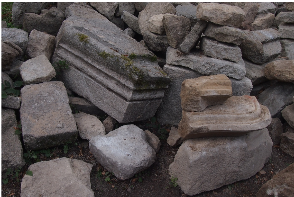
Fig.16/17/18 - Blocs lapidaires cheminée et autres modénatures.
