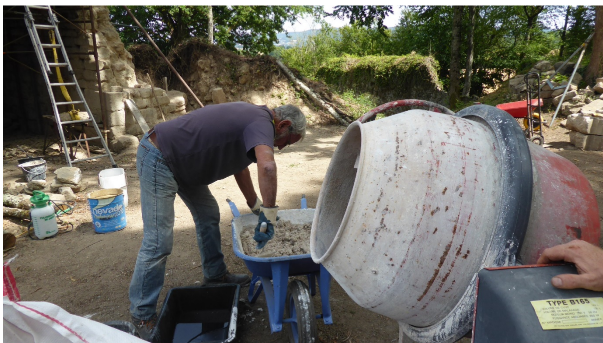
Fig. 19/20 - L'équipe du CeCaB et de l'association « Renaissance du château de Vautheau » en train de consolider la voûte de la tour-porte.
