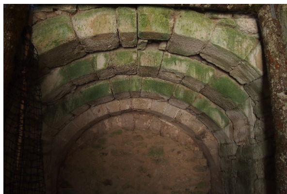
Fig. 4 Tour-porte voûte d'entrée.
