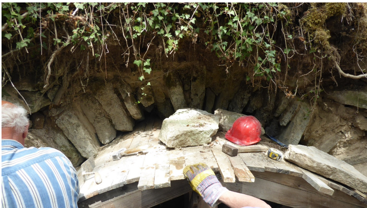
Fig. 2 - Voûte de la tour-porte en cours de consolidations.
